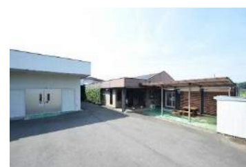
本社工屋・工場
